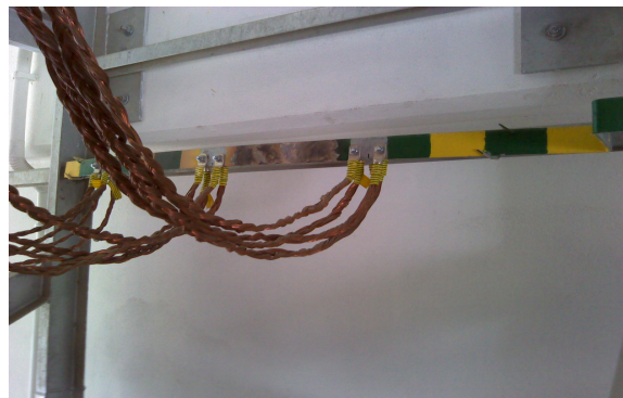
Rys. 1. Wypalone fragmenty farby na bednarce uziemienia
